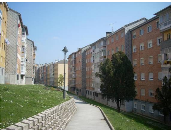
Imágenes de distintos edificios del Barrio de La Luz
